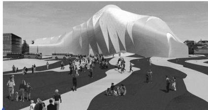
Figure 6. Exemple de segmentation de la forme en surfaces à simple courbure et à double courbure : le projet NOX pour le centre Pompidou.
