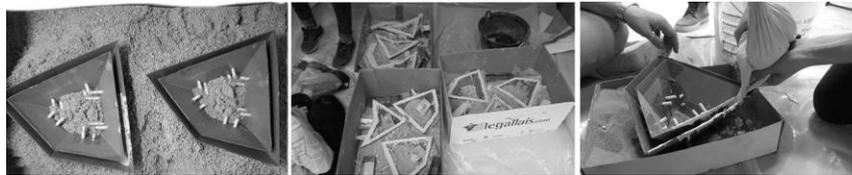
Fig.18: Coulage du béton sur coffrage en carton
