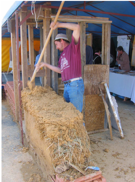
Montage d'un mur en bauge – Source : Maisons Paysannes de France
