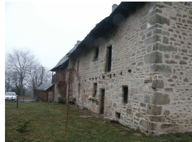
Exemples de mises en œuvre de moellons de pierre - Source : Maisons Paysannes de France
