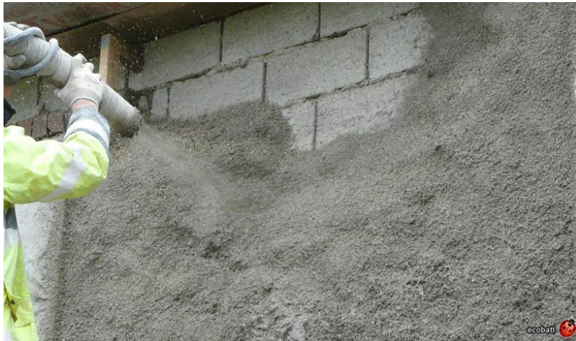
Projection de béton de chaux/chanvre www.ecobati.be/
