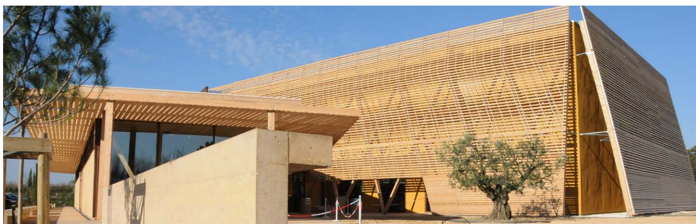
Vue extérieure de la salle polyvalente de Mazan (Vaucluse). Le bâtiment est intégralement réalisé en bois local, l'enveloppe est constituée de caissons isolés avec des bottes de paille qui sont enduits côté extérieur au plâtre gros coloré. Crédit : Bureau d'étude Gaujard technologies SCOP et cabinet DESO Architecture
