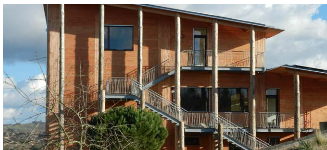
Vue d'un mur pignon du bâtiment tertiaire (R+3) à énergie positive de la société Ecocert - L'isle-Jourdain (Gers). Crédit : Agence d'architecture JF. Collart
