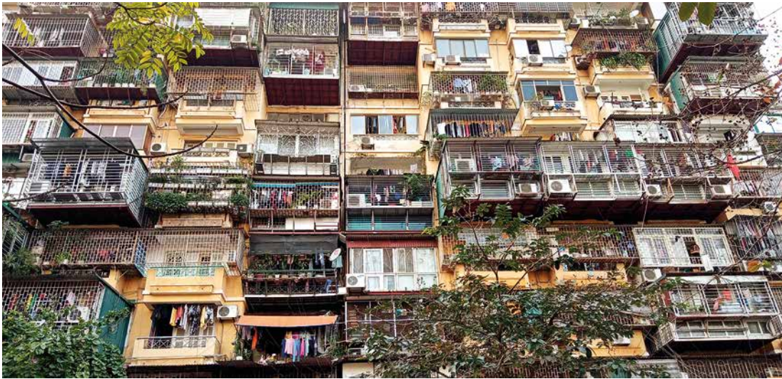
[b] Extensions dans un immeuble KTT, 2019, Hanoi.
