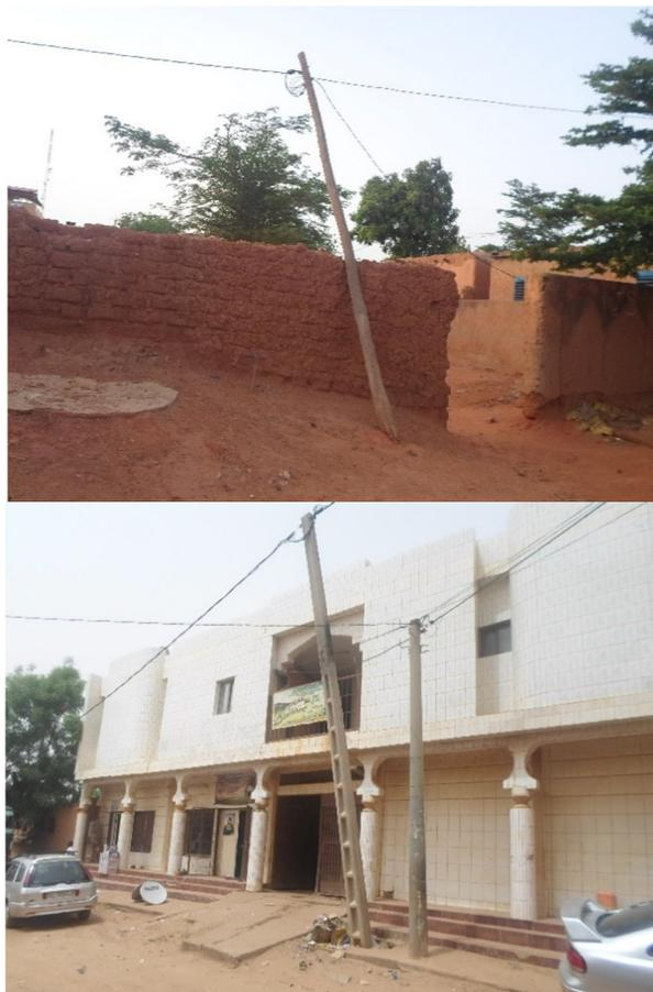
**Photo 1 et 2 : Poteaux électriques en état de dégradation**
