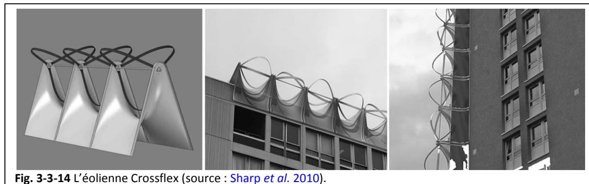
Fig. 3-3-14 L'éolienne Crossflex (source : Sharp et al. 2010).
